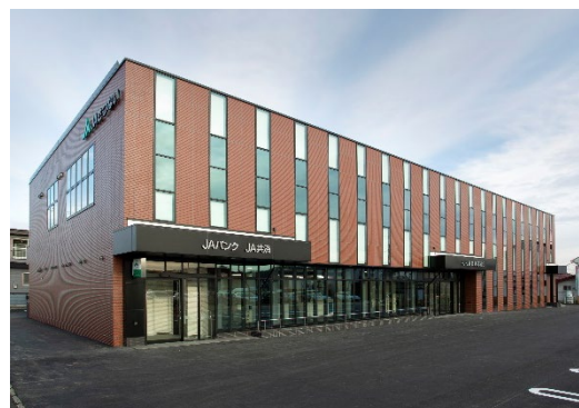
完成した新事務所
