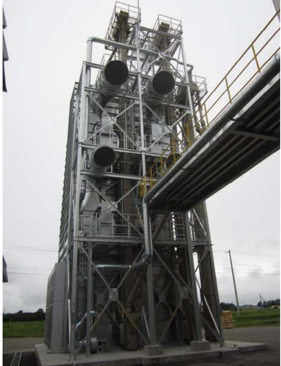
平成22年12月に着工した小麦乾燥貯蔵施設が6月末に完成、7月12日に竣工式が行われました。増収が期待される新品種「きたほなみ」の受入れのため、現在の乾燥貯蔵施設西側に乾燥機（1時間当たり30トンの処理能力）2基、400トンサイロ3基を増設したもので、総工費は約4億円。
